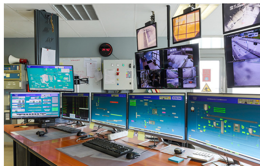
Photo 3 : Salle de quart
