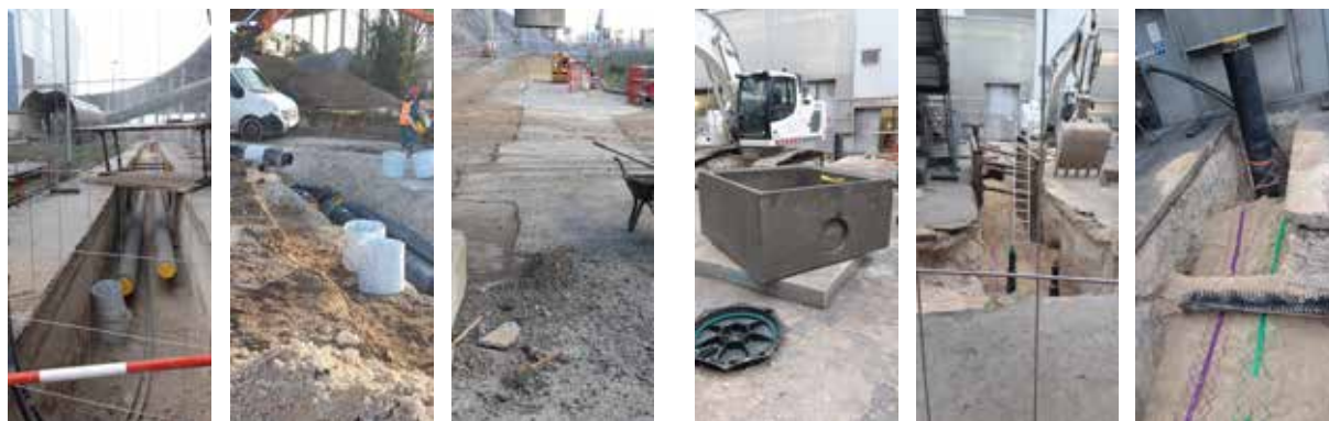
Photo 9 : Mise en œuvre du réseau près de la chaîne des mâchefers
