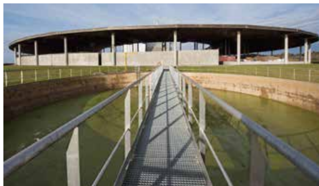
Photo 7 : UVA Bassin A
