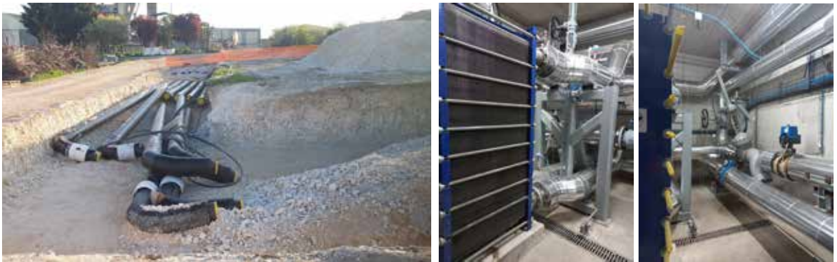
Photo 11 : Lancement des fondations et intérieurs de la sous-station
