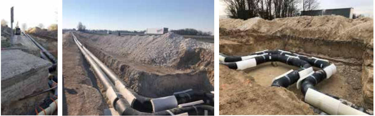
Photo 10 : Pose des canalisations à partir de l'UVE (gauche), en bordure de la N4 entre la Veuve et Recy (milieu) et boucle de dilatation (à droite)
