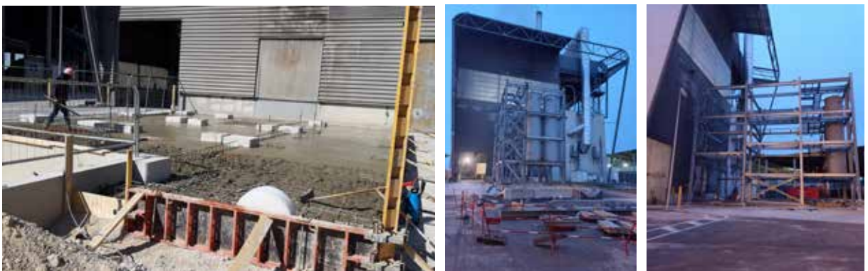
Photo 12 : Fondation du bâtiment DéNox (Oxyde d'azote) et montage
